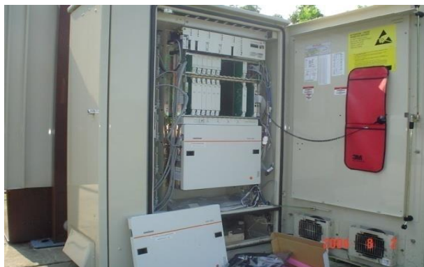
شکل ۹-۵- DSLAM rack [۳۳]
