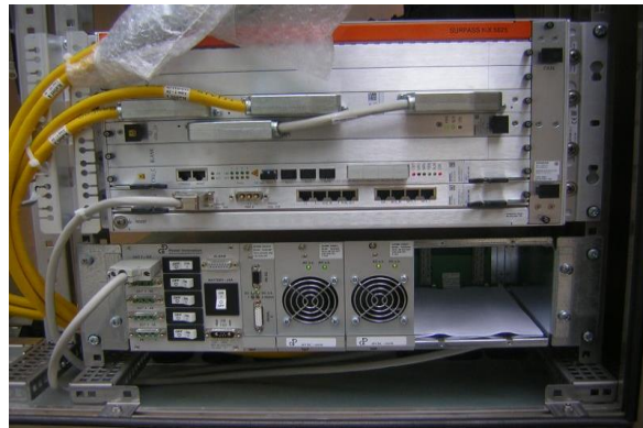
شکل ۹-۴- تصویر تسهیم کننده Siemens DSLAM SURPASS hiX 5625 [۳۳]
