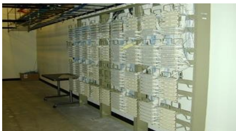
شکل ۹-۶- مرکز MDF شرکت مخابرات [۳۳]
